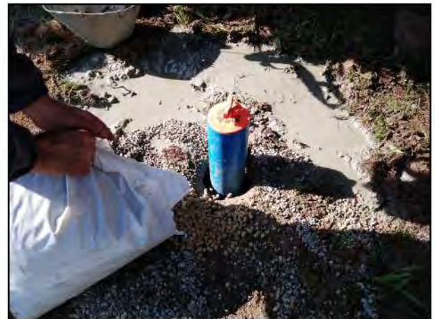
FOTO n.04 Istallazione Piezometro
