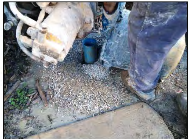
FOTO n.04 Istallazione Piezometro
