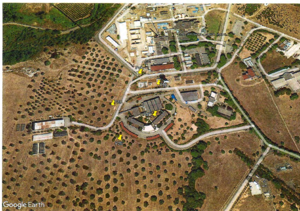
Foto 1 – Ubicazioni Indagini Area 1
