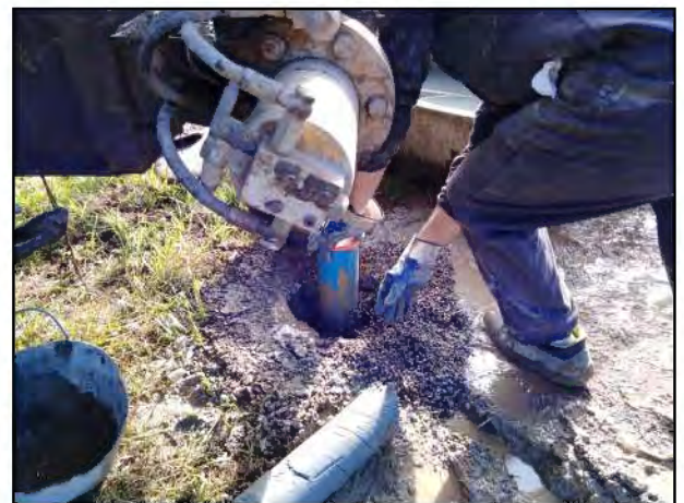
FOTO n.04 Istallazione Piezometro
