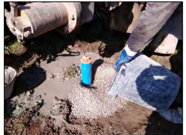
FOTO n.04 Istallazione Piezometro
