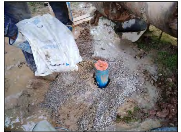
FOTO n.04 Istallazione Piezometro
