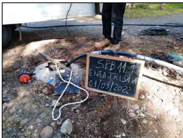
FOTO n.05 Operazione di Spurgo
