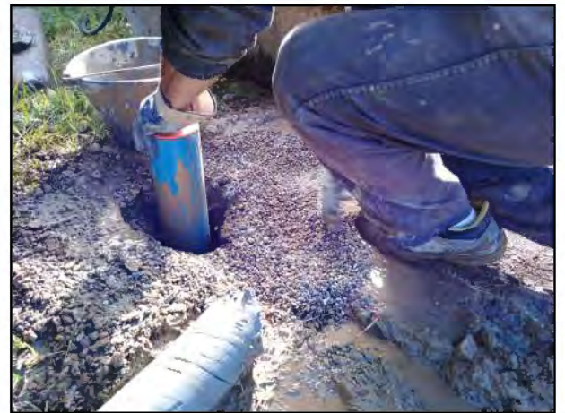
FOTO n.04 Istallazione Piezometro
